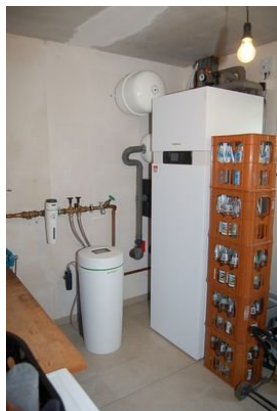
25 Erdwärmepumpe.JPG
